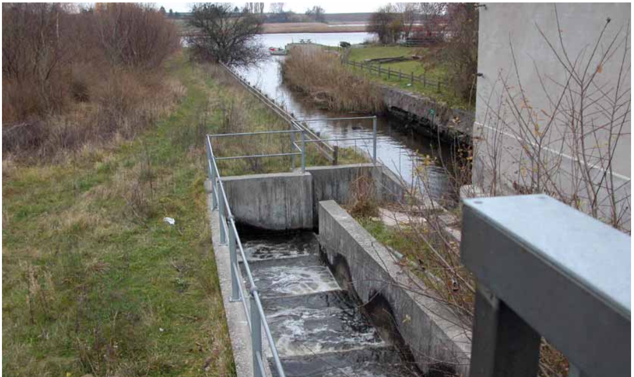
Ørredtrappen ved Kattinge Værk.
